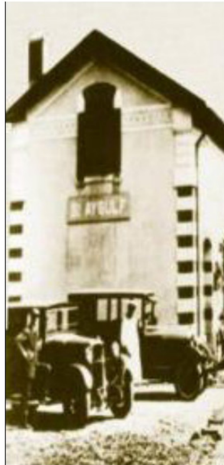
La gare de Saint-Aygulf va accélérer le développement du quartier.
